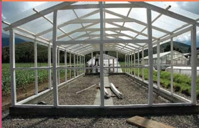
**Figura 9** Invernadero terminado, con techo de plástico y antecámara.
