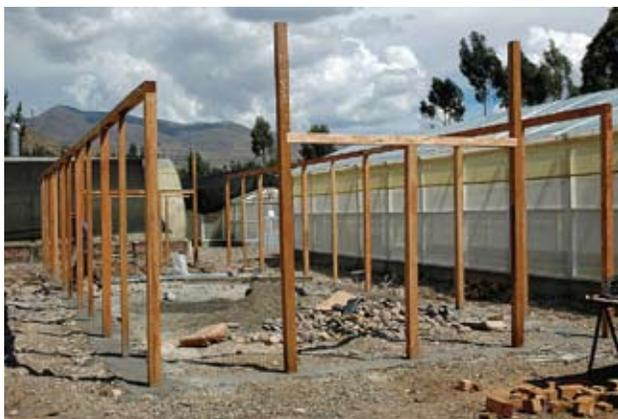
**Figura 7** Distribución de las columnas de madera ancladas en el cemento en un invernadero de 15 x 5 m.
