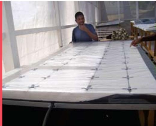
**Figura 22** Recubrimiento externo e interno de las tapas del cajón. Notar también el recubrimiento de los agujeros con tubos pvc.
