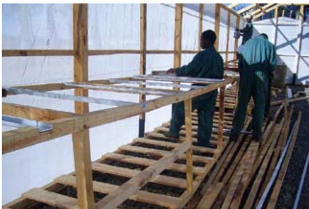
**Figura 18** Un módulo de aeroponía en construcción en Njuli, Blantyre-Malawi. El armazón de los cajones es de madera. Las barras superiores son de aluminio, que es costoso. Estas pueden ser reemplazadas por madera u otro material recubierto por plástico.
