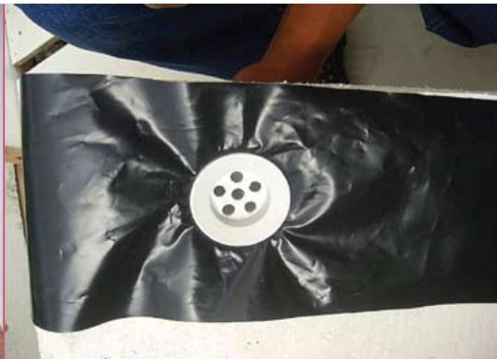
**Figura 25** Detalle del sumidero de desagüe en el piso del cajón. Un sumidero de lavatorio se acopla a través del plástico negro y la tubería de desagüe que conecta al tanque.
