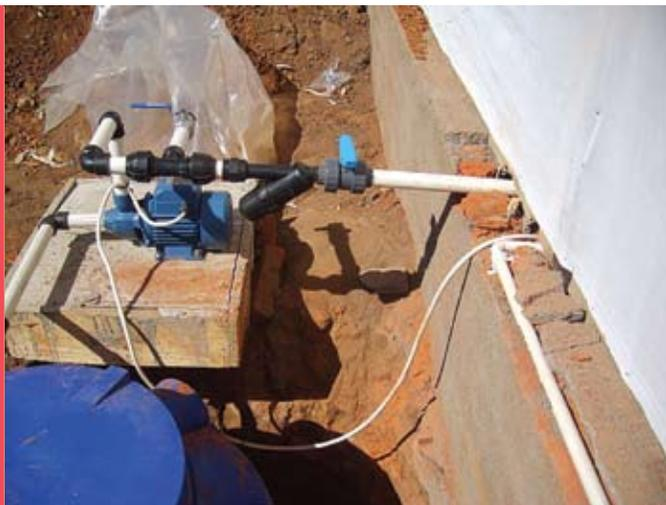
**Figura 24** Instalación externa del tanque y bomba. La llave azul encima de la bomba sirve para vaciar la solución nutritiva del tanque. La llave general (cerca del filtro negro) necesita estar cerrada. Módulo aeropónico en Njuli-Malawi.
