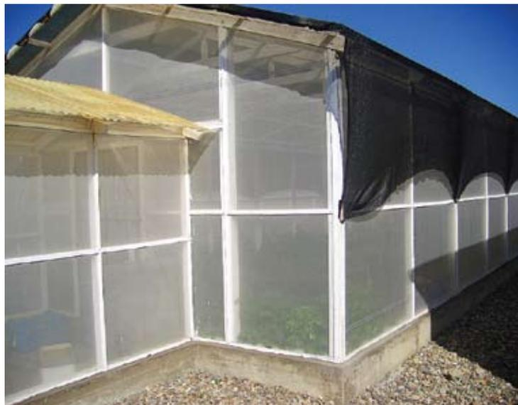
**Figura 11** Invernadero con diferente tipo de instalación de malla sombreadora. Esta instalación permite sombrear solo cuando hay excesivo calor.
