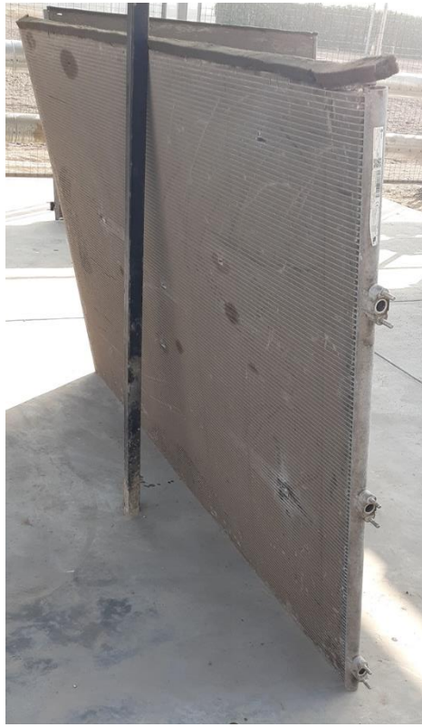
Figura 2. Panel de condensación de sistema de Chiller RTAF 115Ton.
