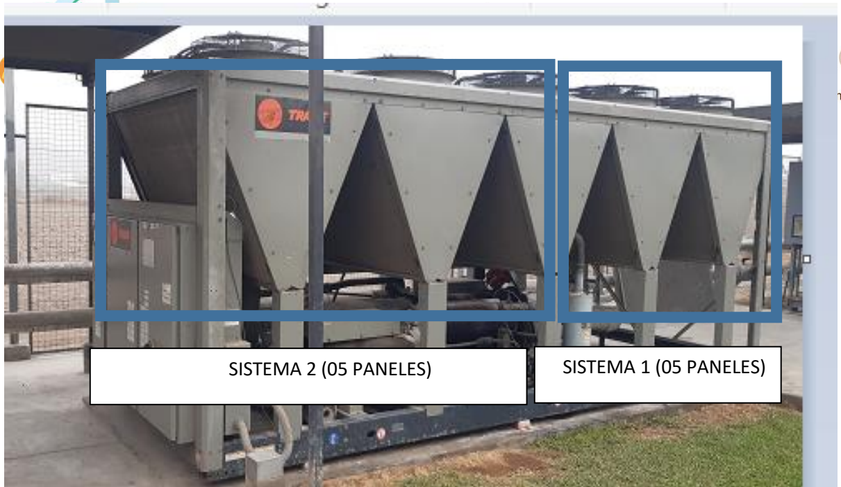
Figura 1. Sistema de Chiller RTAF 115Ton.
