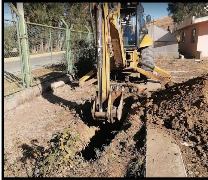
*Extracción de muestra para determinar capacidad portante del suelo*
