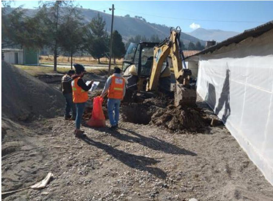
**ÁREA DONDE SE CONSTRUIRÁ INVERNADERO, SE OBSERVA LA TOMA DE MUESTRA PARA DETERMINAR LA CAPACIDAD PORTANTE DEL SUELO**
