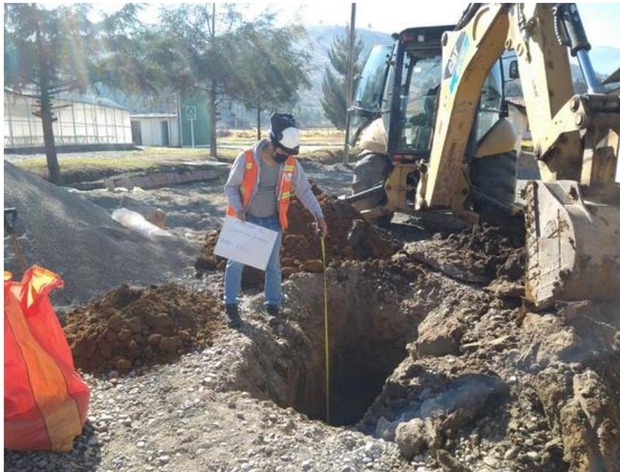
**ÁREA DONDE SE CONSTRUIRÁ INVERNADERO, SE OBSERVA LA TOMA DE MUESTRA PARA DETERMINAR LA CAPACIDAD PORTANTE DEL SUELO**
