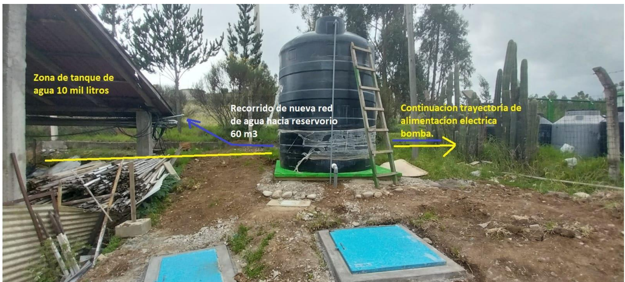
Fig. 04 Continuación de recorrido de la alimentación eléctrica y proyección de red de agua hacia reservorio.
