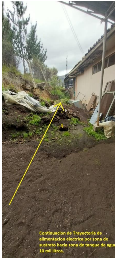
Fig. 03 Zona de sustrato con interferencias, requiere nivelación, trazo y replanteo para recorrido de alimentación eléctrica.
