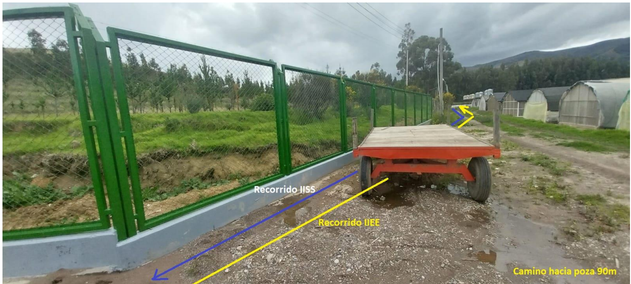
Fig. 06 Zona de invernaderos, cerco perimétrico.
