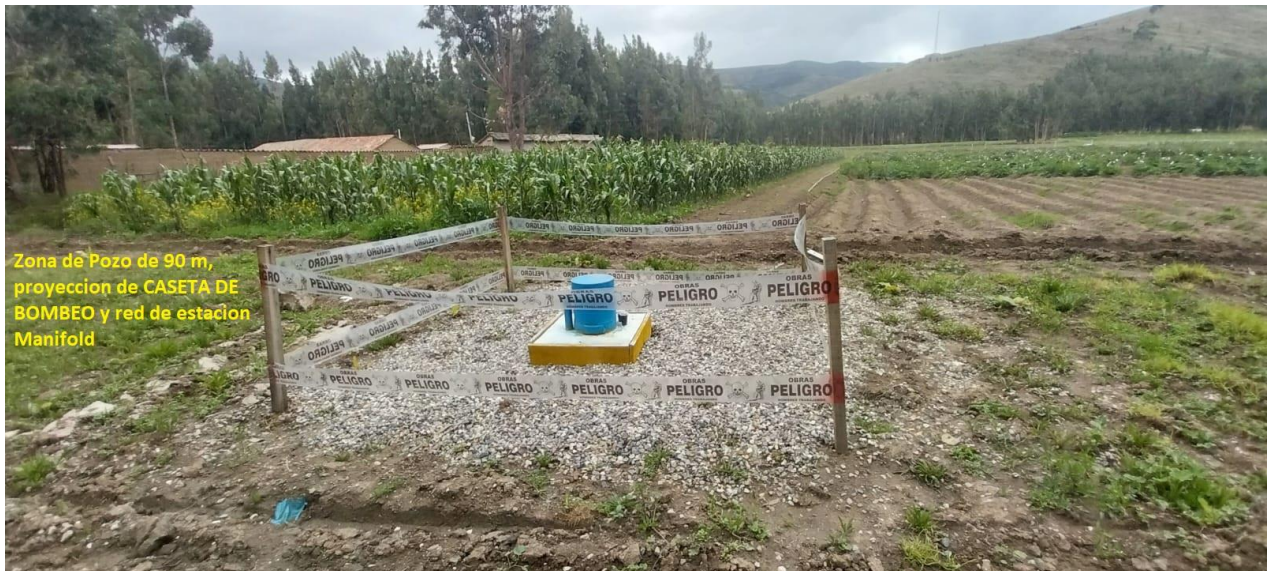
Fig. 10 Zona de punto de pozo 90m, construcción de caseta de bombeo y punto inicial de estación de manifold.
