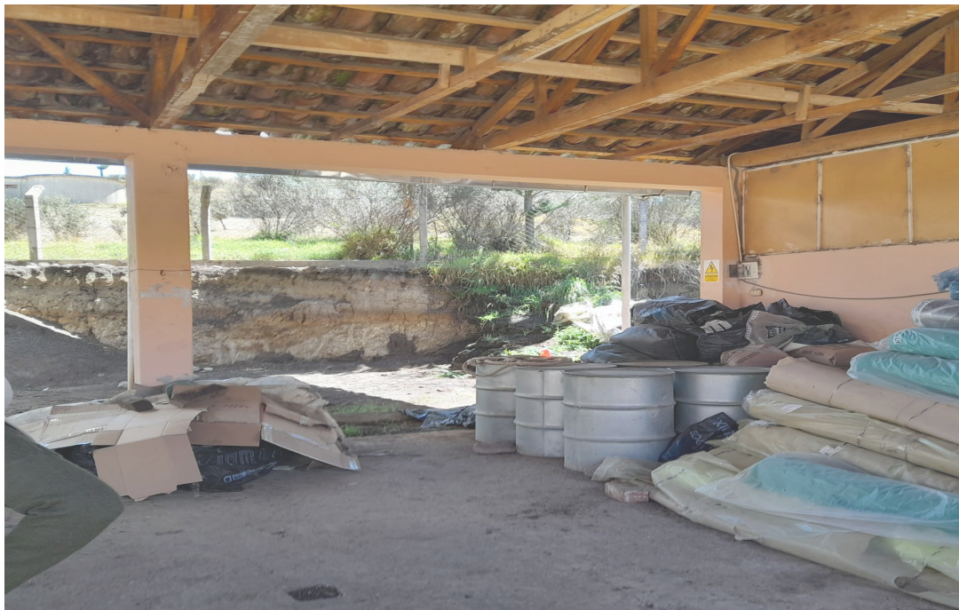
VISTA DEL AREA DESTINADA PARA EL CUARTO DE ESTERILIZACION
